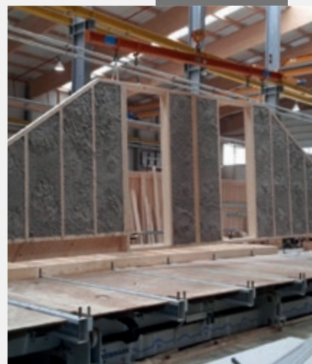
Fiberna packar ihop sig i konstruktionen till en skräddarsydd isolerskiva, utan skarvar och glipor.
